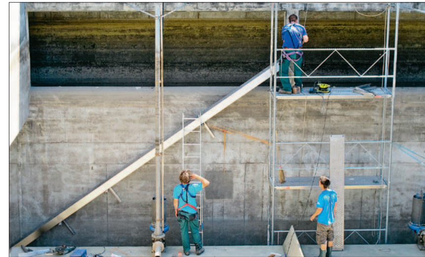
Albert von Felten (oben) montiert mit zwei «Zivis» die Ausstiegshilfe
