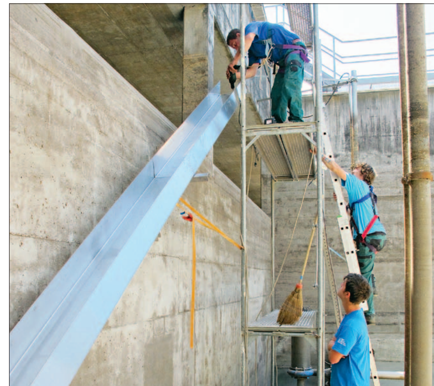
Albert von Felten (oben) montiert mit zwei «Zivis» die Ausstiegshilfe
